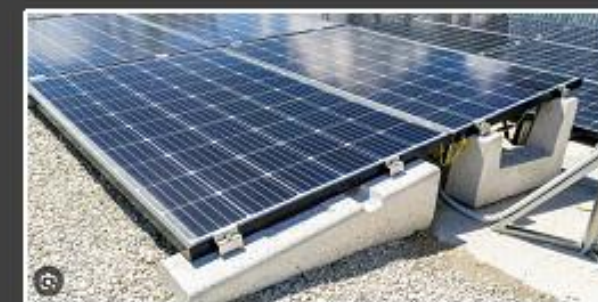
ESEMPIO INSTALLAZIONE ZAVORRE PER TETTI PIANI 11 GRADI DOPPIA FILA
